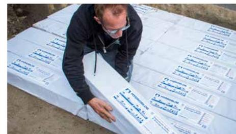
Placer le nombre de blocs désirés en fonction de la surface et du type de sol.
